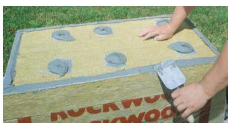
На плити наносимо клей на поверхню, як це показано на малюнку
