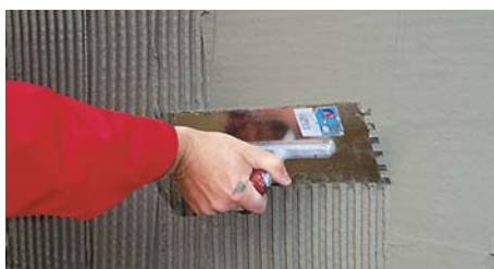
Армований розчин необхідно наносити за допомогою шпателя із зубами 10x10 мм
