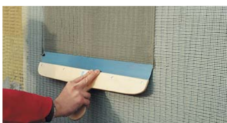
У свіжий і однакової товщини армований розчин утаплюємо сітку із скловолокна (зверху вниз) по всій висоті стіни
