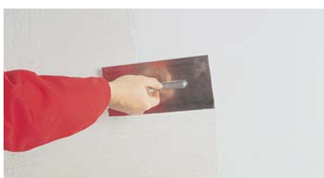
Штукатурний розчин укладаємо і наносимо теркою з пластмаси
