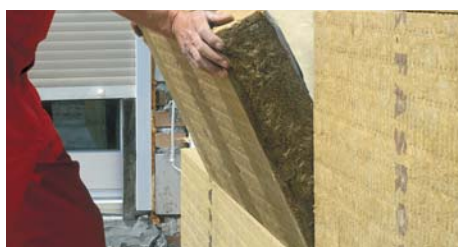
Надлишки клейового розчину з боку плити прибираємо так, щоб їх не було видно на стиках плит
