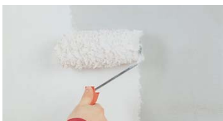
Нанесення ґрунтовки
