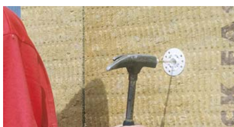
Кріплення плит з'єднувачами. Вставляємо пластиковий з'єднувач і забиваємо легкими ударами молотком
