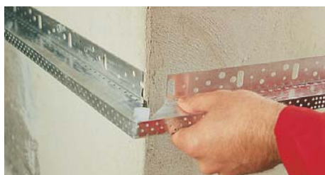
Монтаж цокольного профілю
